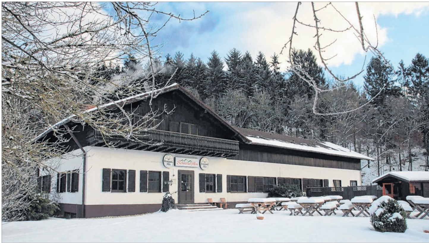
Sofern die Netphener Politik ihre Zustimmung erteilt, wird das Landhaus an der B 62 zwischen Netphen und Dreis-Tiefenbach bis auf den Keller abgerissen. An Ort und Stelle würde ein Hotel mit 43 Zimmern, Gastronomie und Mehrzwecksaal entstehen. Foto: wette
